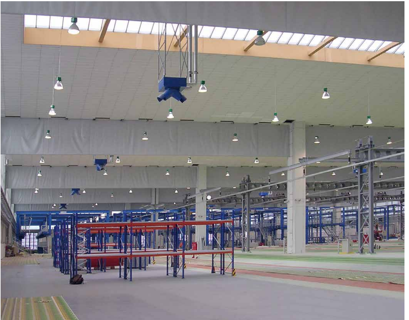
Werkshalle Deutsche S-Bahn, Frankfurt
