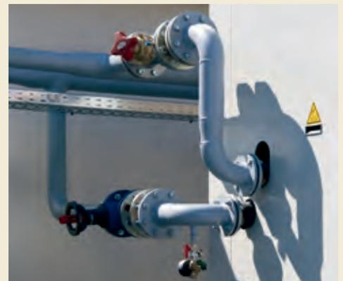
Kaltwasseranschlüsse mit Absperrventilen für War-
